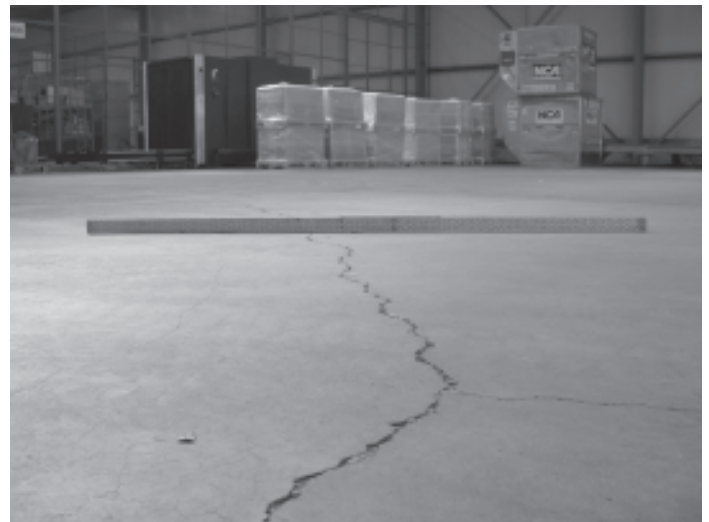
Afb. 4 Gescheurd beton.
