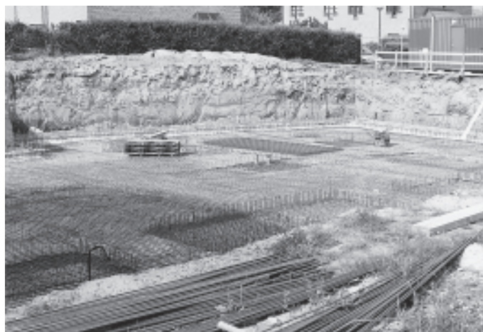
Afb. 3 Wapeningen op de bouwplaats.
